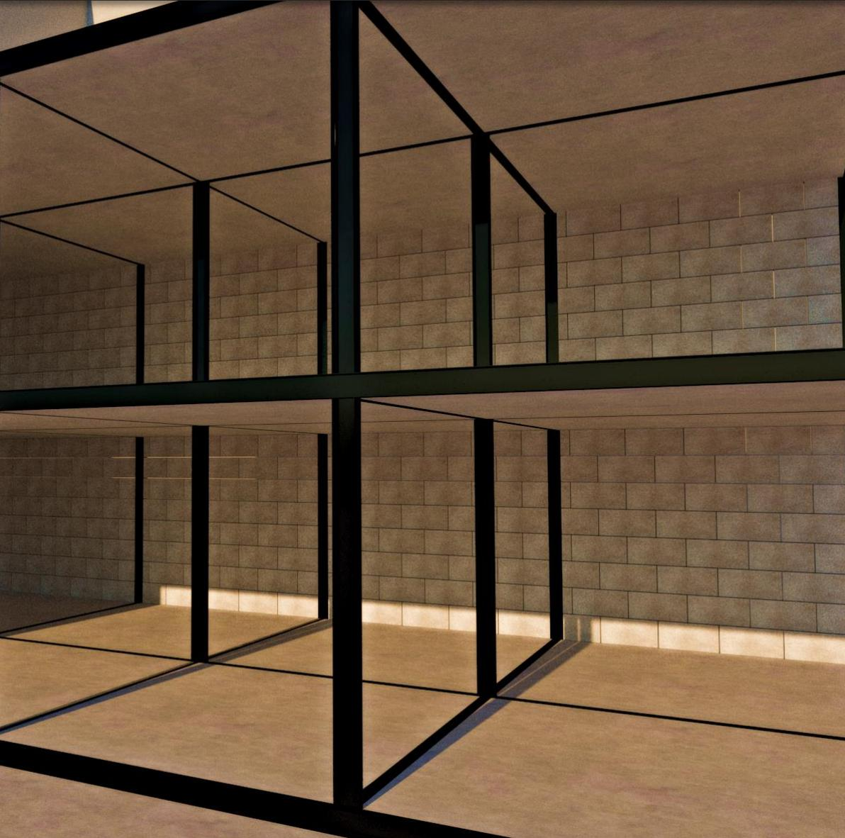
O Isobloco é leve ( $850\text{Kg/m}^3$ ) e, com isso, podemos ter de 15% a 20% de redução de custos da fundação.
