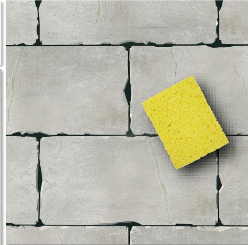
Para corrigir as imperfeições existentes, deve-se regularizar o preenchimento das juntas com Isocola e realizar o acabamento com o auxílio de uma esponja umedecida.
