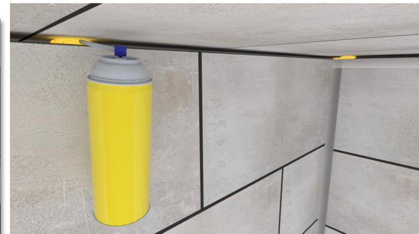
O topo da alvenaria e o fundo da viga ou laje somente deverão ser executados após a conclusão de toda a estrutura da edificação.
