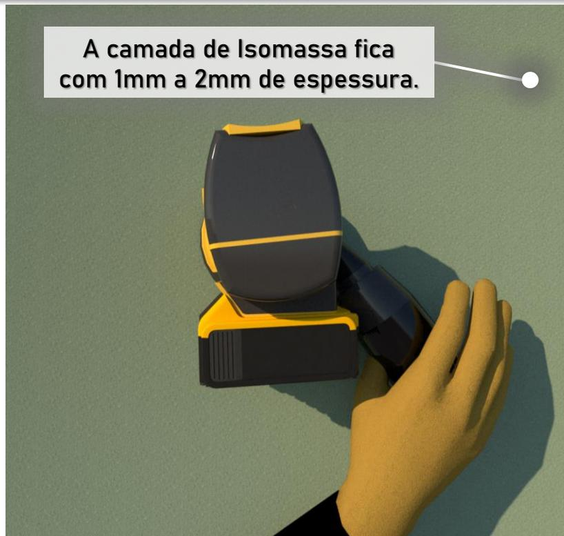
A Isomassa deve ser aplicada sobre o Isobloco pelo menos 24h após a montagem da parede ou laje. A aplicação é feita com uma desempenadeira de aço em duas demãos e o produto vai pronto para uso.
