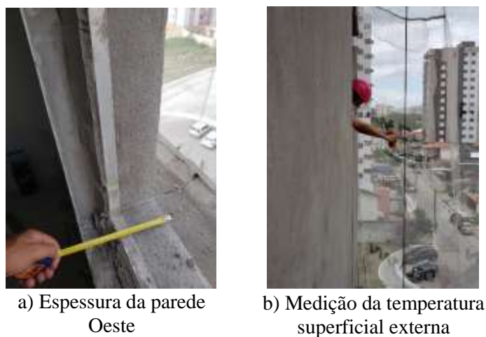
Figura 2 – Levantamentos realizados in loco.
